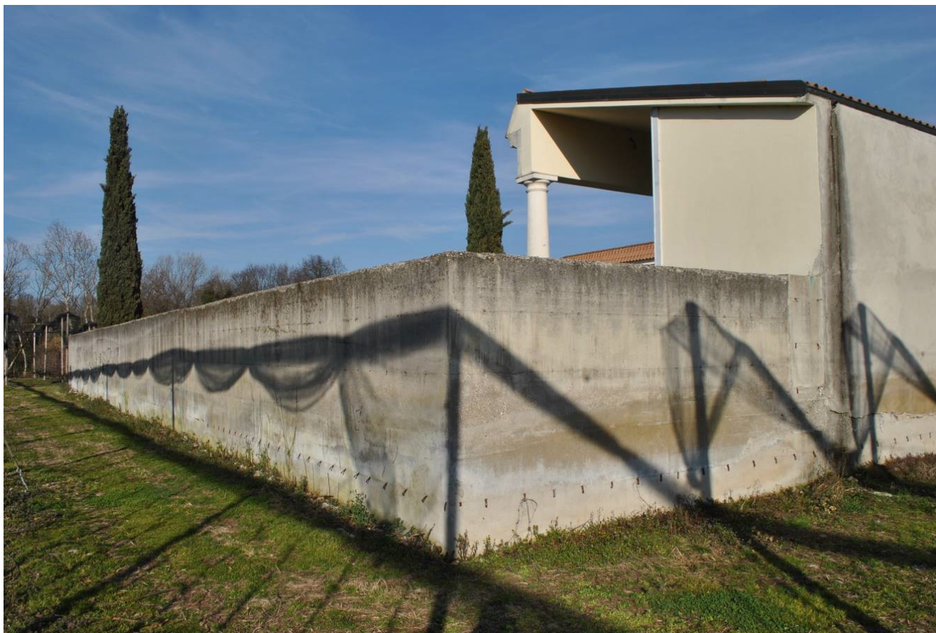
Figura 6 - vista dell'ambito LOTTO 1 dall'esterno del perimetro cimiteriale
