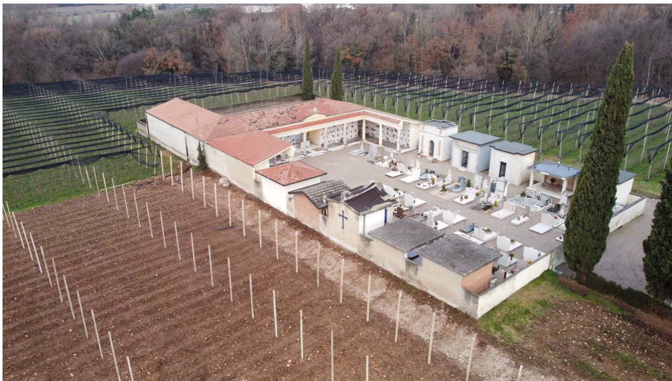
Figura 2 - vista aerea da drone (vista verso nord-ovest)
